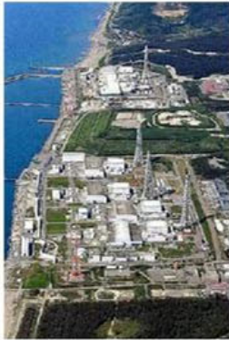
東京電力の柏崎刈羽原子力発電所。手前が1～4号機、奥が5～7号機。新潟県柏崎市・刈羽村
